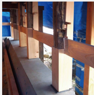
柱の金輪継ぎ
