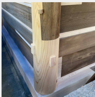
柱の金輪継ぎ、土台と壁板の繕い
