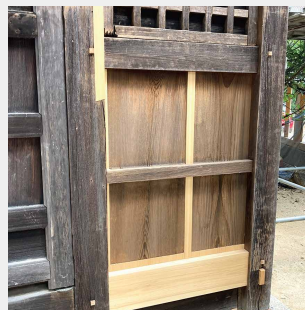
柱と壁板の繕い
