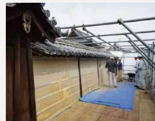
現状調査の様子
