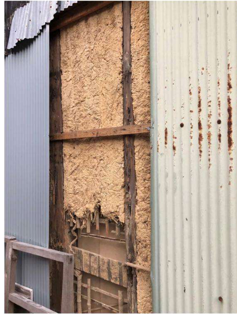
南面外壁下地の痕跡調査
