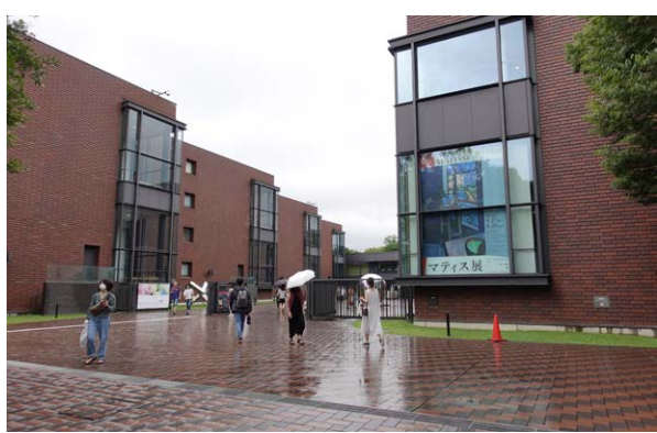
南側の正面アプローチからの全景。右側が改修された企画棟。
