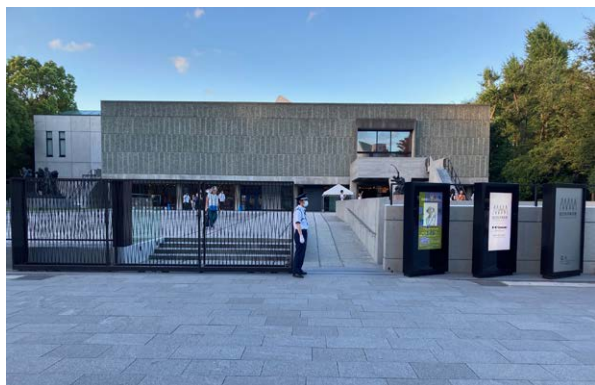
国立西洋美術館本館の南側正面外観
