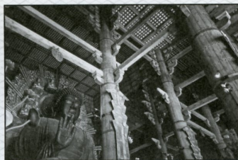
東大寺大仏殿の内部の柱と梁の構成。
