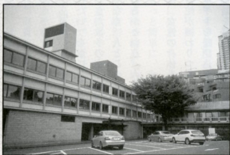
北側アプローチ外観。
