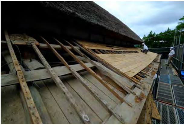
▲野地板を取り外した状態 舞台正面（北面）
