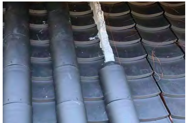
▲本瓦 丸瓦は南蛮漆喰で固定し全数を銅線で留め付け
