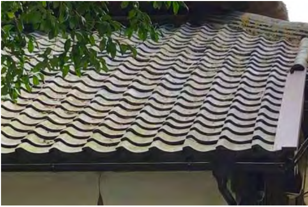
▲棧瓦葺屋根／化粧部屋 軒棧瓦は模様入り鎌軒瓦
