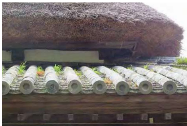
▲本瓦葺屋根／舞台正面 軒丸瓦は蛇の目紋
