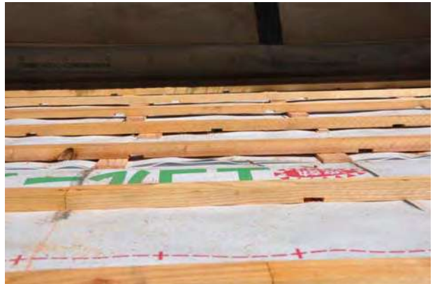
▲栈木 水抜き穴
