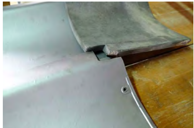
▲棧瓦 隅は原形に倣い鋭角に調整加工した
