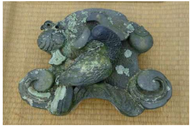
▲北西の鬼瓦 分解直後 製作鬼瓦外形の基本形とした
