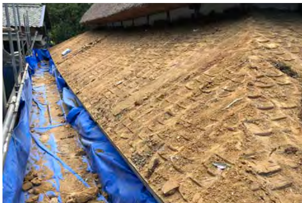
▲瓦降ろし後、葺き土撤去前 舞台正面（北面）
