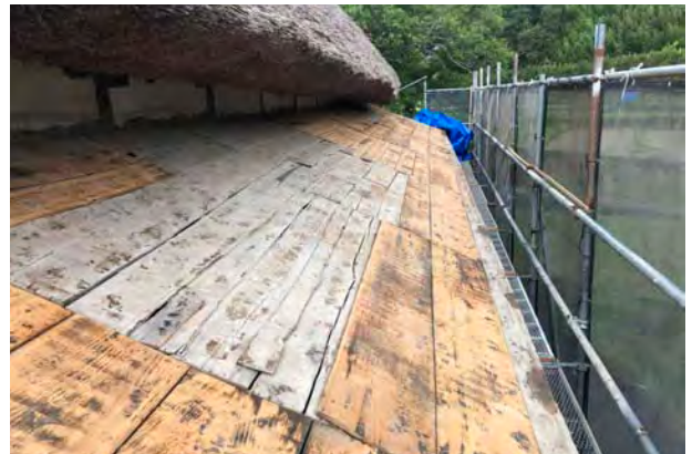
▲瓦降ろし後の野地板 舞台背面（南面）
