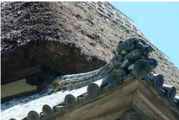
▲隅棟／北西 鬼瓦は鳩の文様 熨斗は4段で納める
