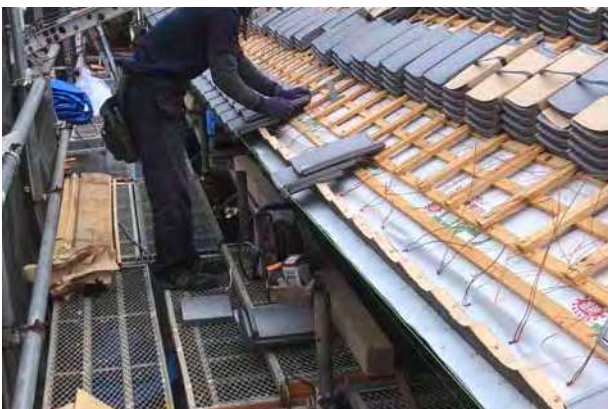
▲本瓦 平瓦施工 瓦座は瓦にあわせて新たに製作した
