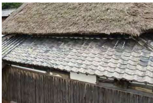
▲棧瓦葺屋根／舞台西面 蛇の目紋万十瓦と万十瓦
