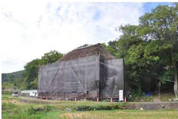
▲外部足場 舞台背面（南面）
