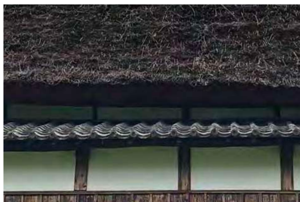
▲棧瓦葺屋根／舞台背面 軒棧瓦は蛇の目紋万十瓦
