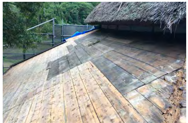
▲瓦降ろし後の野地板 舞台下手（東面）
