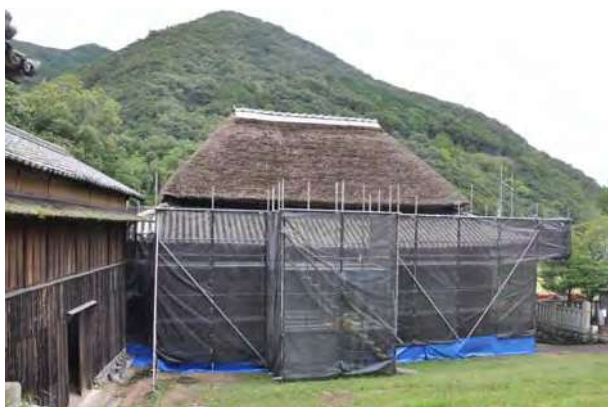
▲外部足場 舞台正面（北面）
