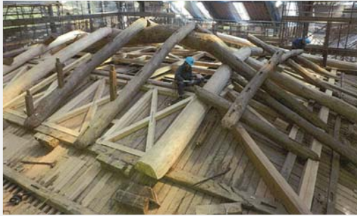
木製筋違による補強
