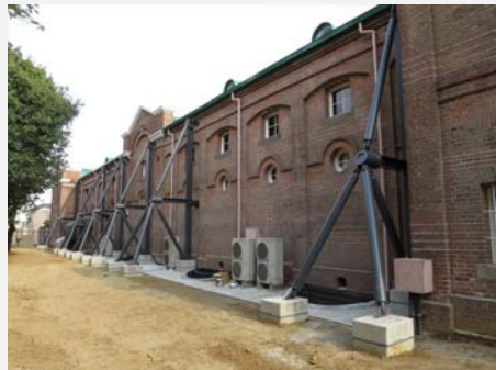
重要文化財 シャトーカミヤ旧醸造場施設 醱酵室
