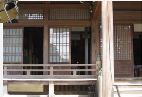
補強鉄骨:正面から
