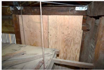
合板耐力壁補強
