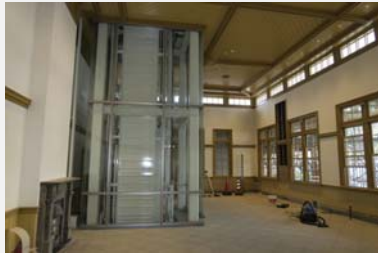
補強フレームがエレベーターシャフトを兼ねる
