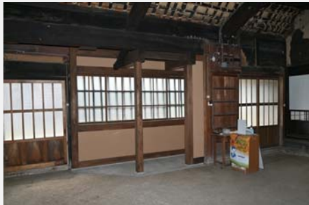
土間にフレーム補強
