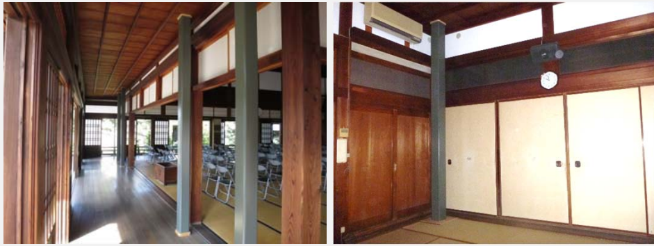
正面廊下:補強鉄骨
