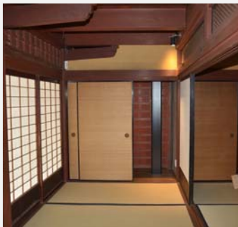
鉄骨フレーム補強
