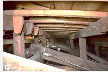
向拝:水平構面補強
