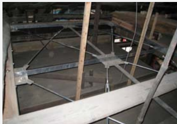
鉄骨柱と鉄筋ブレースによる補強
