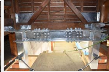
鉄骨フレーム補強上部
