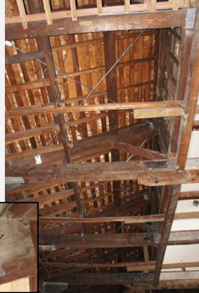
鉄筋ブレースによる補強
