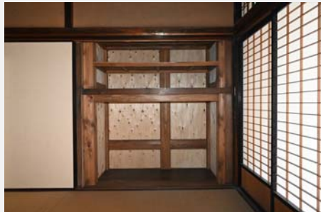
押し入れに合板フレーム補強
