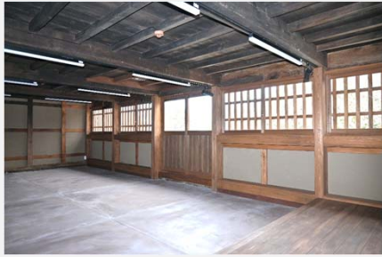
内部フレーム補強(サッシを設けて活用兼用)
