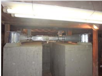
正面廊下:補強鉄骨
