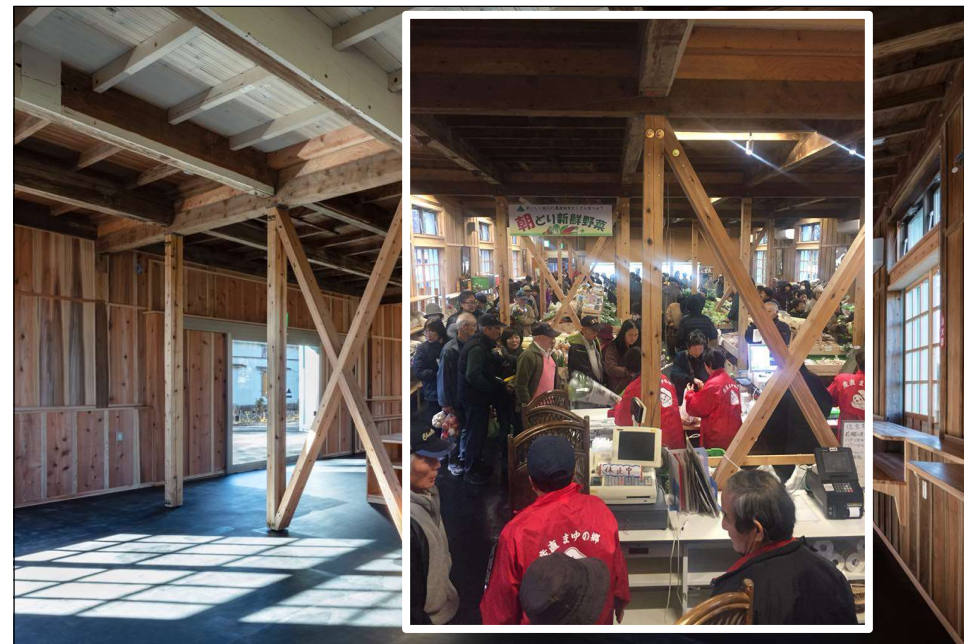
第五蚕室：1階／木造ブレース補強
