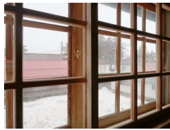
【2階建具】 外部側／既存引違い木建具 内部側／新設引違い木建具
