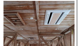
【2階空調】 既存の天井内に ヒートポンプパッケージエアコンを埋込み (換気とできるだけ見せない)
