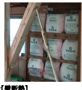
【壁断熱】 高性能グラスウール_t100
