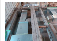
【1階空調】 既存の床下内に 吹出・吸込ダクトを配管 床面ガラリに接続 (換気とできるだけ見せない)
