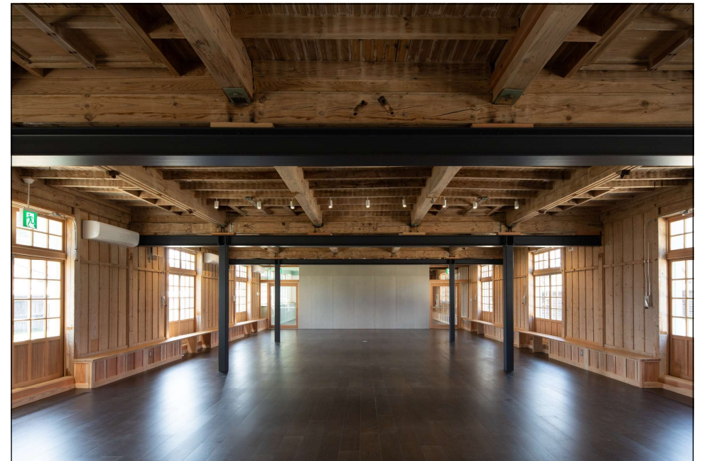
第一蚕室：1階（イベントスペース）／鉄骨補強
