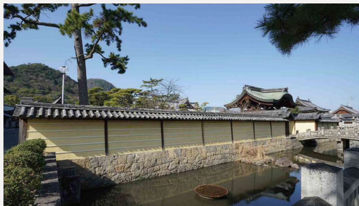
完成(南東から)
