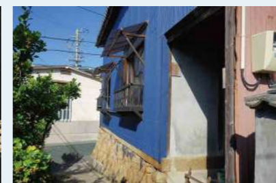
【壁の間に設けられた入り口】
