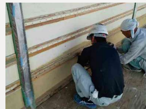
定規筋の下地にステンレスビスと針金の芯棒を取り付け
