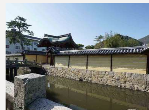
完成(北東、仁王門前から)
