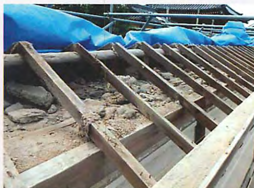
土堀上部の屋根構造
