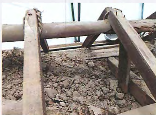
垂木に和釘と洋釘が混在した
